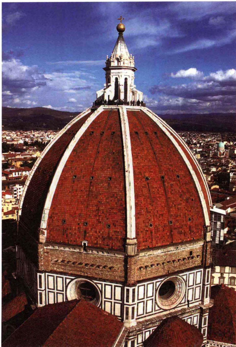
图2 圣母百花大教堂。1296—1436年。佛罗伦萨。布鲁内莱斯基设计并组织建造其穹窿顶（直径45.5米）。它是有史以来最大的砖造圆顶
